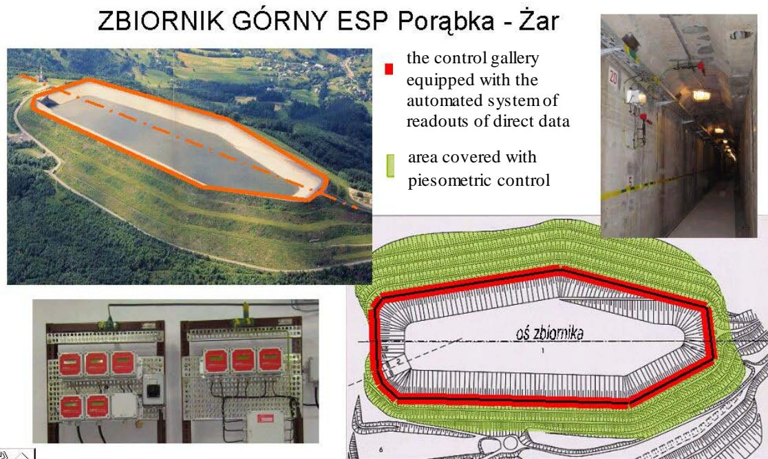
*Fig. 5. The upper reservoir, ESP Porąbka - Żar*
