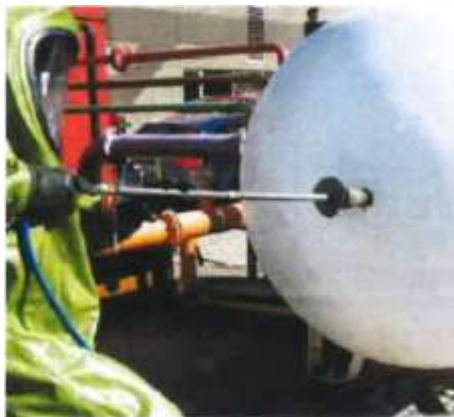
3.att. Bojātas tvertnes hermetizācija, izmantojot pneimatisko tapu
