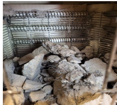
Fig.6. Broken SFRC Specimens
