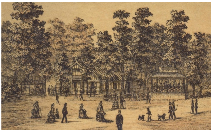
7.attēls. “Šveiciešu stila” paviljons atpūtai Pilsētas parkā (LM-3)
